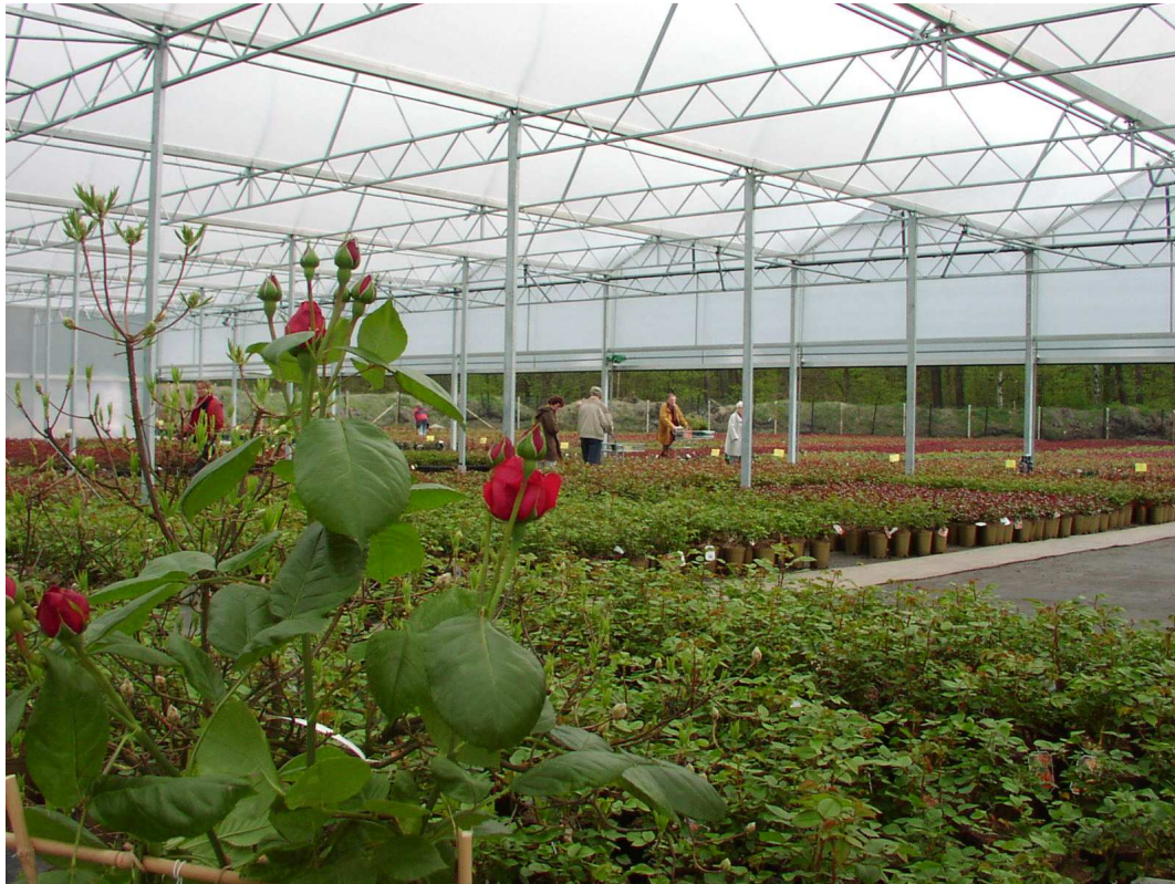
Foliengewächshaus, Dacheindeckung mit Doppelfolie, aufgeblasen sowie Doppelfolie in Giebel- und Stehwänden. Dach mit einseitiger durchgehender Lüftungsklappe je Dachkappe.
