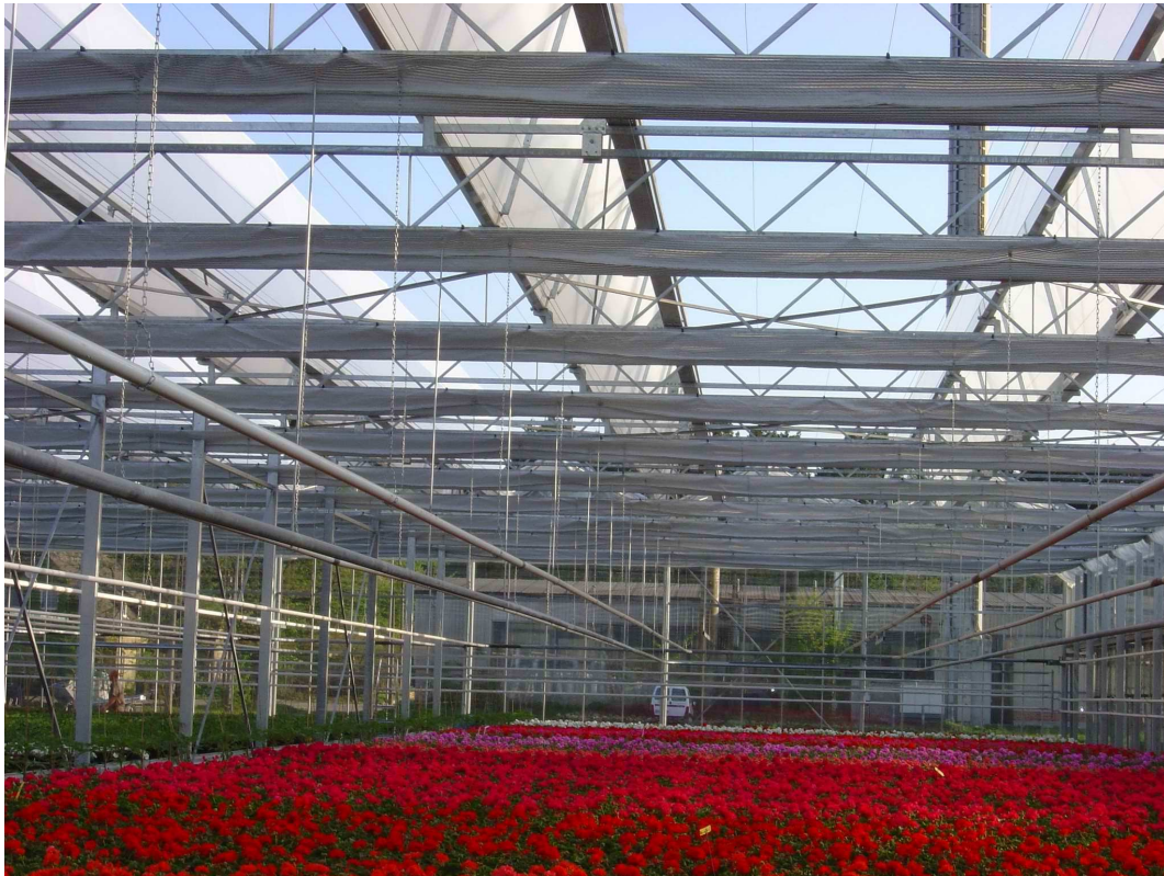
Cabrio-Gewächshaus mit Folieneindeckung im Dach sowie Glaseindeckung in den Giebel- und Stehwänden. Cabrio-Lüftung mit nahezu vollständiger Öffnung des Daches durch kappenweise Faltung der Dachkappen in Richtung der jeweiligen Rinnen.
